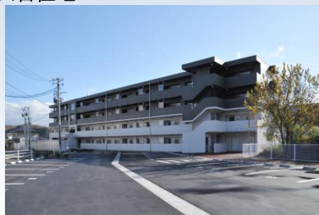
黒沢尻団地（北上市） 令和元年11月完成
