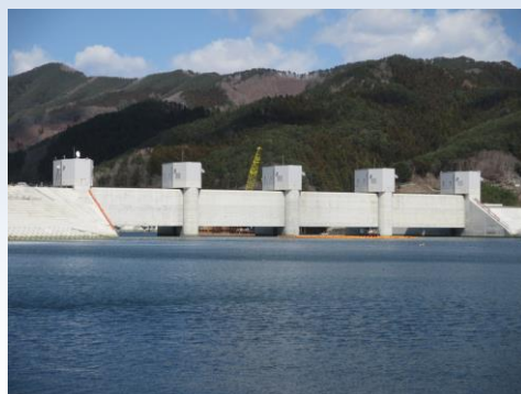
大槌川水門（令和2年2月完成）
